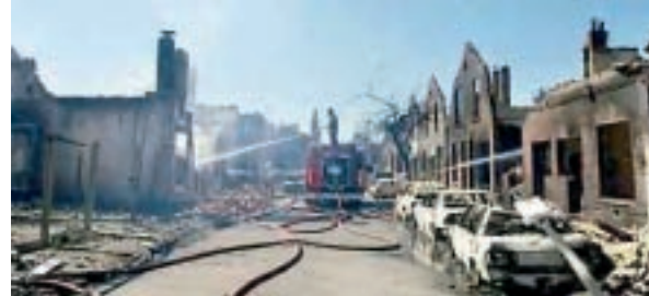
Widok zniszczonej ulicy w Enschede po wybuchu „pirotechniki” w zakładach SE Fireworks
