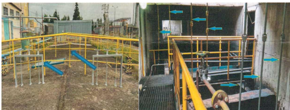
Widok łapacza mazutu wraz z wyprowadzonymi Zaworami na zewnątrz.
