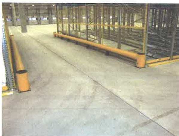
Rys. 2-26. Stosowanie barier chroniących regały w nowo budowanym magazynie (ilustracja dzięki uprzejmości firmy Evergrip sp. z o.o., Warszawa)
