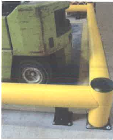
Rys. 2-4. Wydzielenie miejsca do parkowania wózka z zastosowaniem bariery z tworzywa sztucznego (ilustracja dzięki uprzejmości firmy Evergrip sp. z o.o. 1 , Warszawa)
